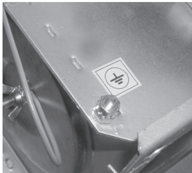
Kuva 4. Palopellin maadoitusruuvi
